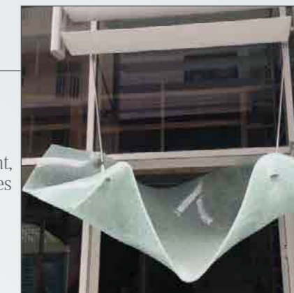
2 broken 6+6 glass plates. 2 plaques en verre 6+6 cassées.
